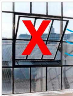
ไม่ติดตั้งใกล้หน้าต่างที่เปิดตลอดและไม่สามารถควบคุมอุณหภูมิและความชื้นให้กับเครื่องได้
